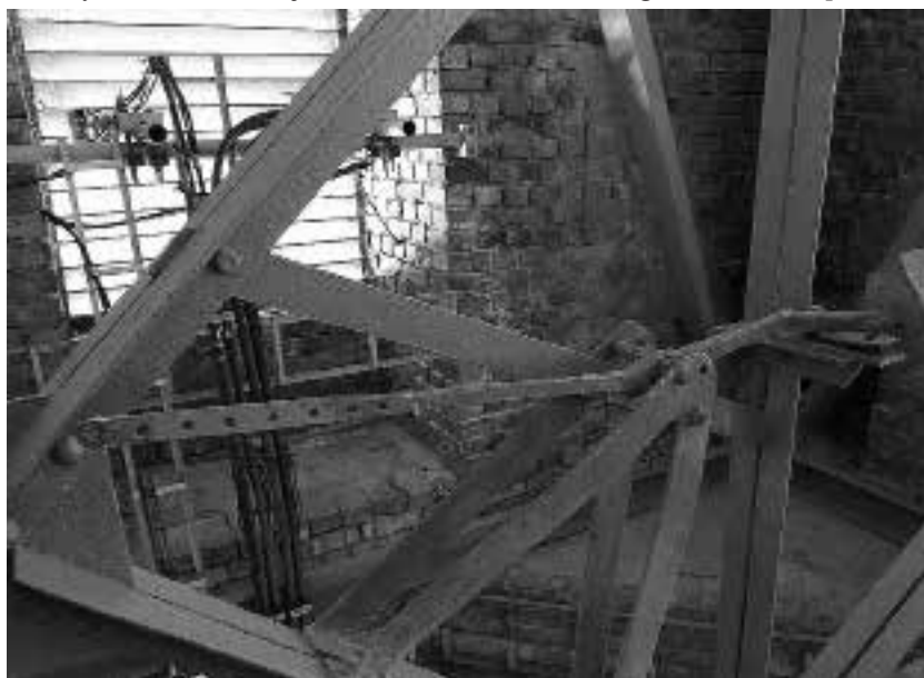
Il. nr 5: Zachowany element mechanizmu młotkowego zegara Hörza do największego dzwonu [fot. B. Skop].
